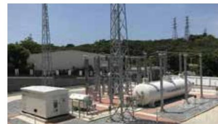
国际上首个输电电压等级的160kV超导直流限流器
